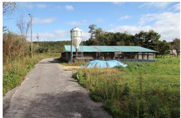
養鶏場の全景(幹線道路入口から100m)
